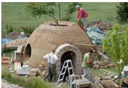
„Workshop“ s Gernotom Minkem, stavba kupoly z nepálených tehál v Hrubom Šúri
